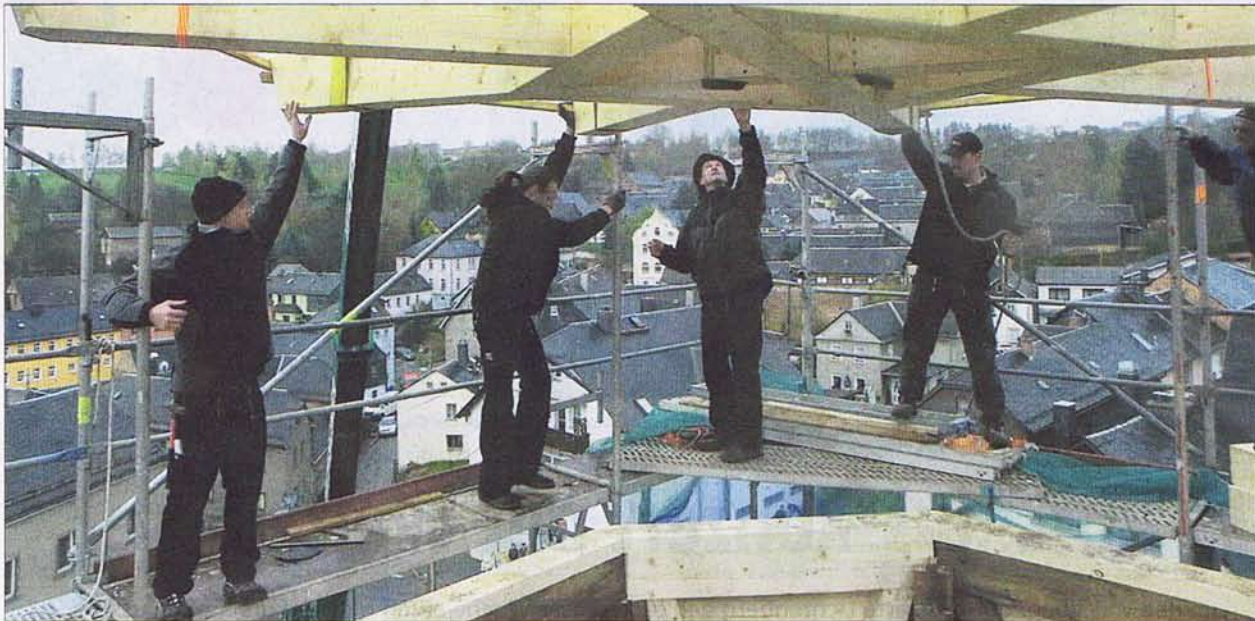
Die Holzkonstruktion der einschwebenden Turmhaube wird von den Zimmerleuten aufgesetzt.
